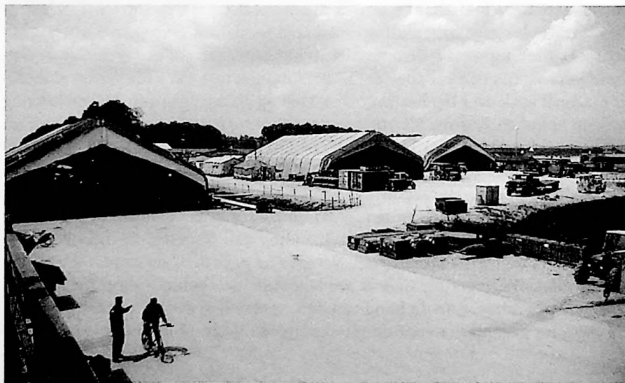
Onderhoudshangars op Comanche Base (Bron: R. Adang)
