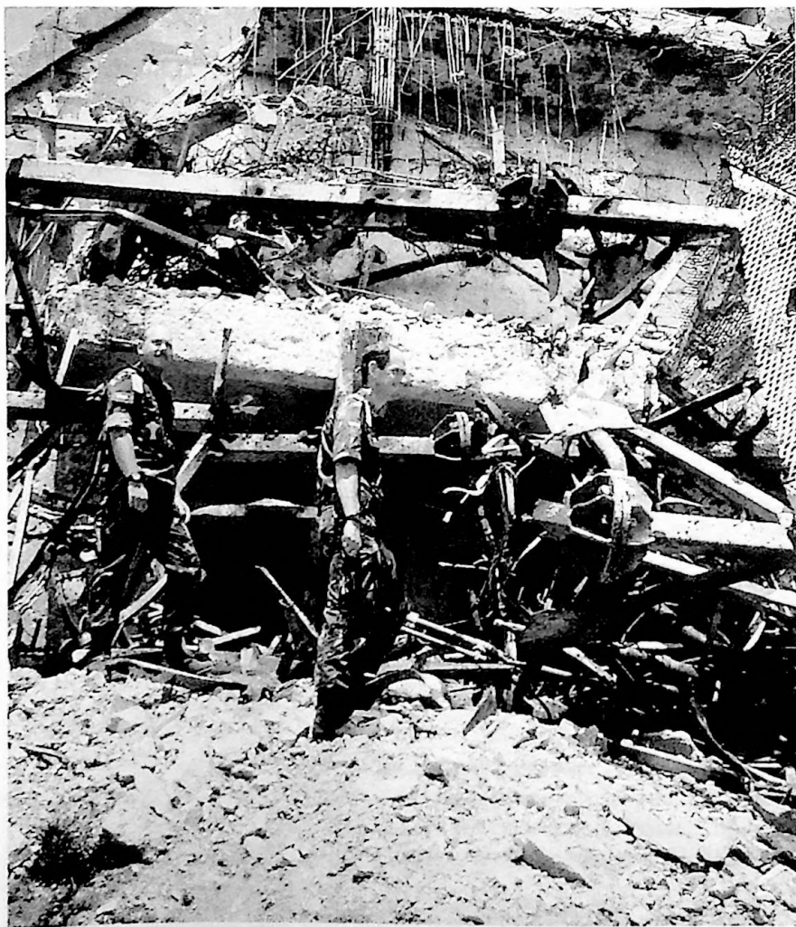
Door kruisraketten van de NAVO vernielde communicatiebunker (Bron: Van den Aker)
